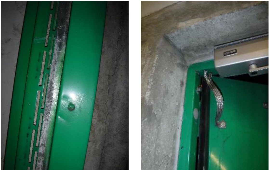
Figure 24 – Dégradation portes - issue 474
