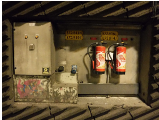
Figure 45 - Coffret pompier en tête d'ouvrage
