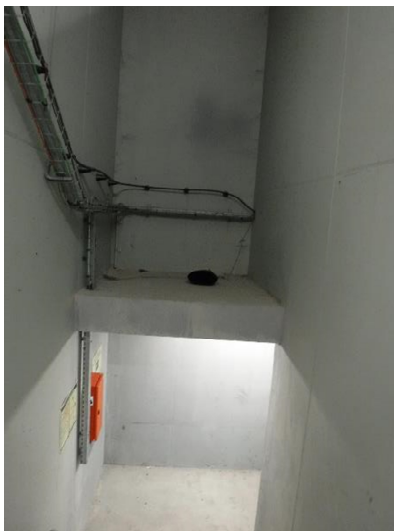
Figure 18 – Chemins de câbles présents dans les issues de secours
